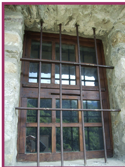
Fenêtre de la sacristie
