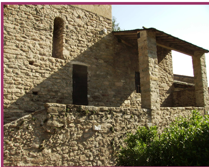
Base du clocher, étage supérieur de l'église
