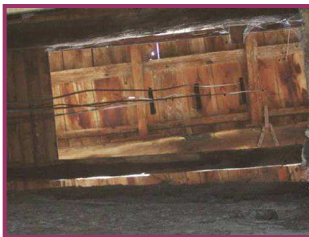
Charpente du clocher
