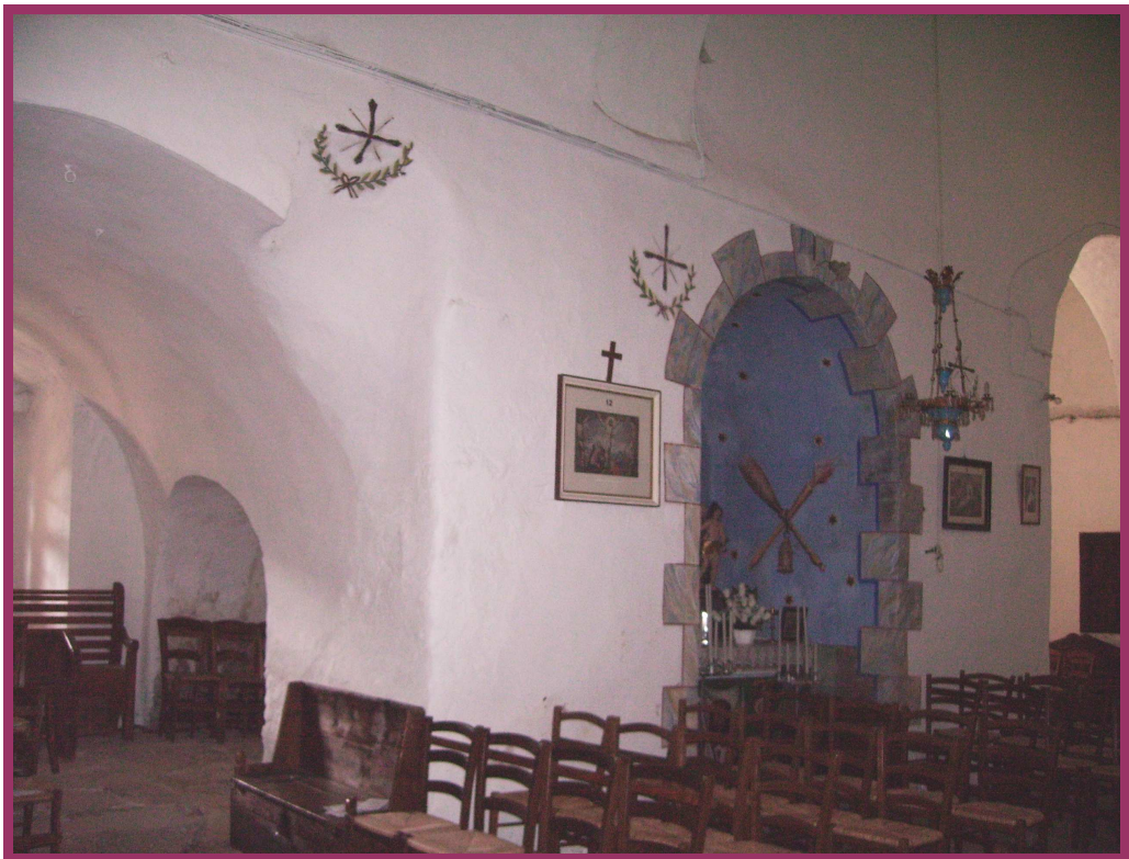
Pilier de soutien du clocher tour
