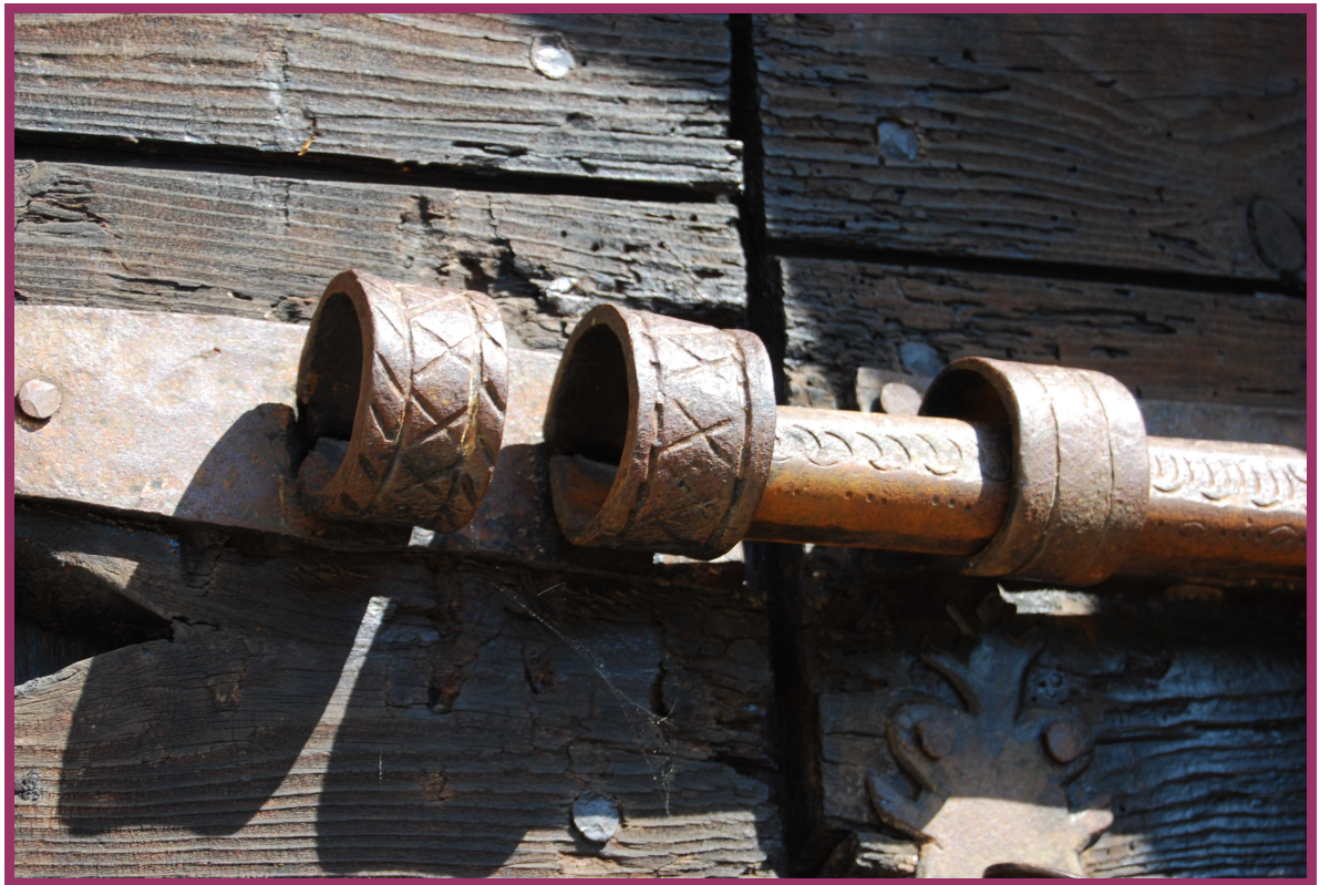
Détails de la ferronnerie
