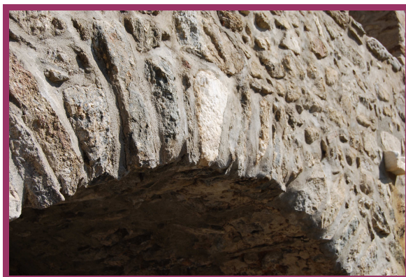
Arc en plein cintre extérieur
