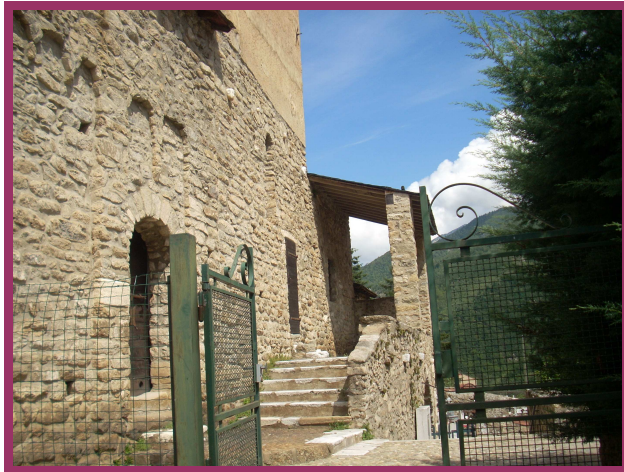
Façade et auvent
