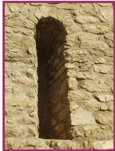
Fenêtre à double ébrasement
