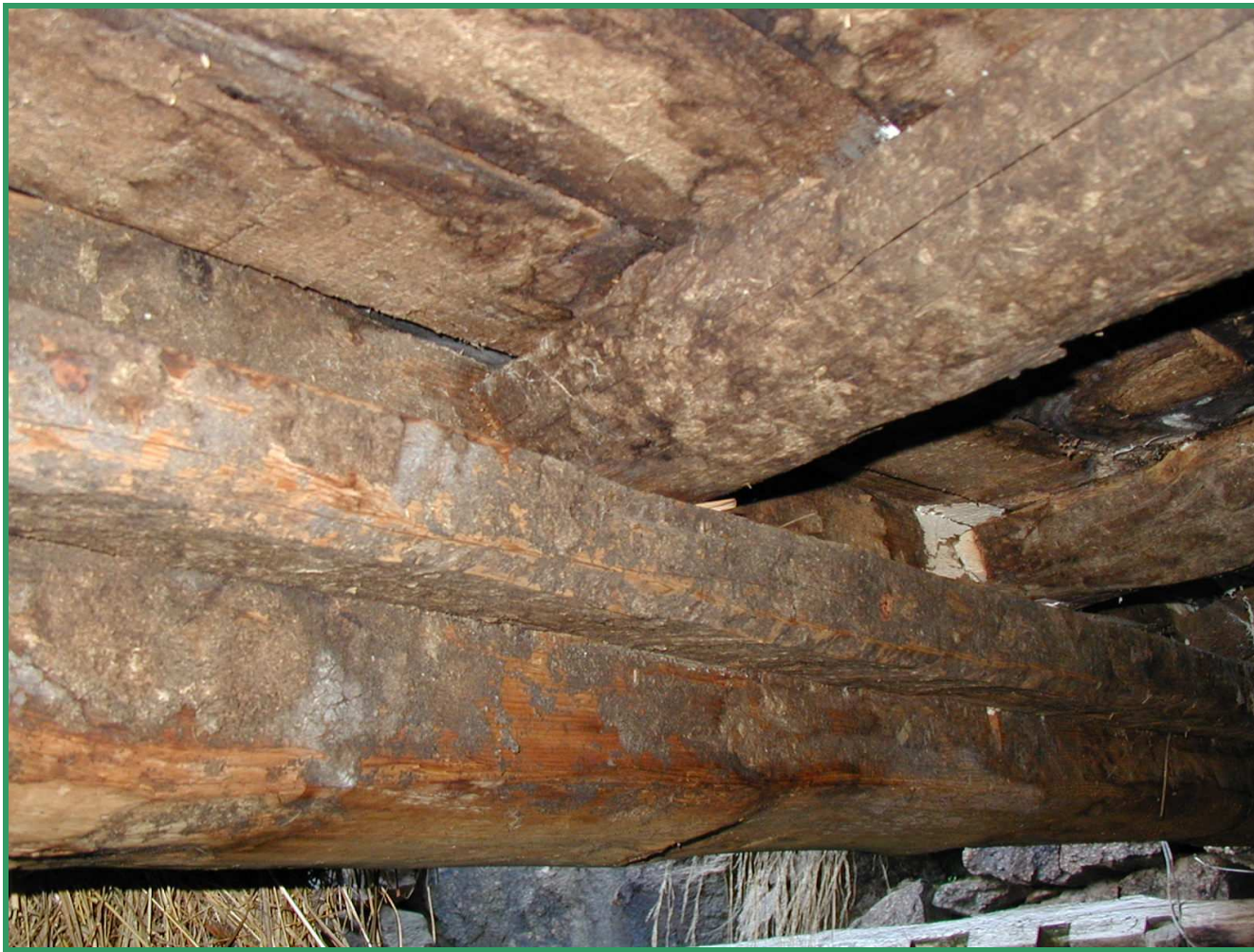
Charpente en sapin et plancher en pin, cortal du « Clot d'en Vila »
