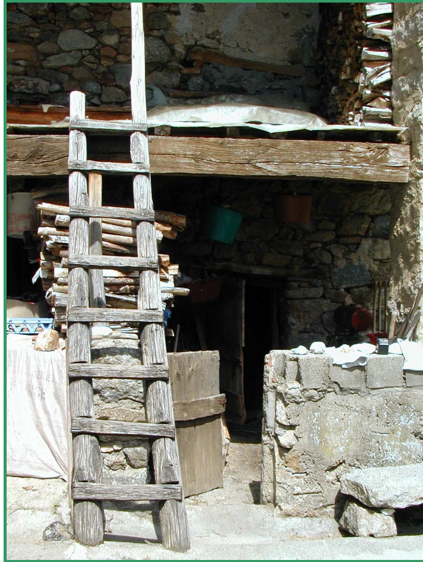
Poutre et échelle en châtaignier du « cortal del Terrer »
