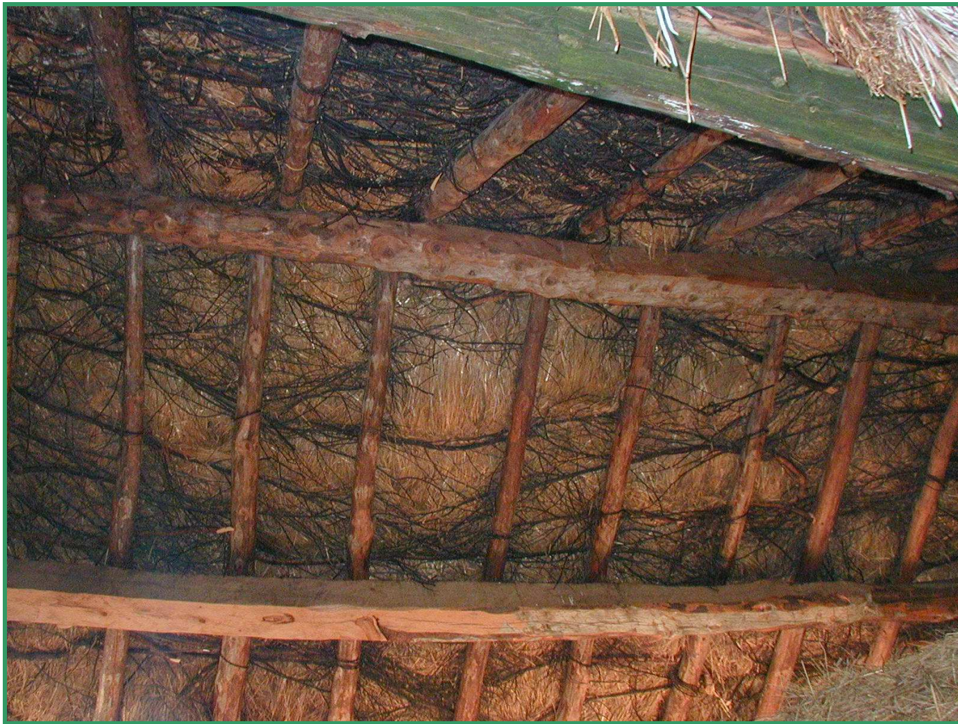
Toit de chaume de seigle, chevrons en bois de pin « cortal del Clot d'en Vila »
